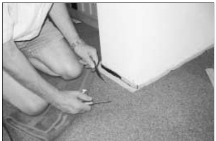
Abb. 2: Vorbereitung einer Randfuge für das Einbringen einer wasserdampfdurchlässigen Barriere, die gasförmige und partikuläre Schimmelpilzbestandteile aus dem Unterboden zurückhält
