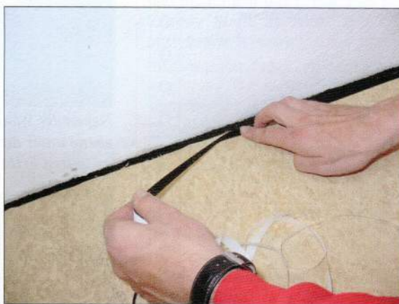
Danach, Aufbringen des selbstklebenden Hakenbandes ...
