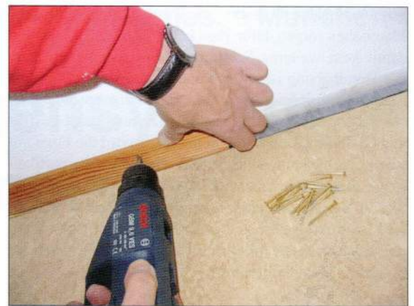
Zum Schluss wird das Estrichfugensystem durch eine abnehmbare Sockelleiste verdeckt
