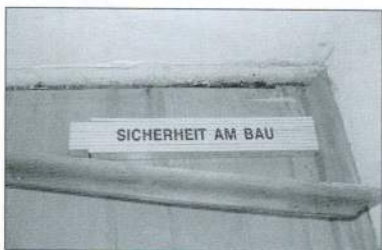
Eine Schimmelpilzbelastung des Unterbodens ist bis zur Randfuge vorgedrungen
