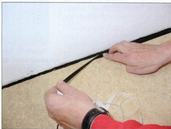
Danach, Aufbringen des selbstklebenden Hakenbandes ...
