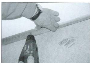
Belastete Randfugen als Indikator für belastete Unterböden (alle Fotos: www.Welindo.de )
