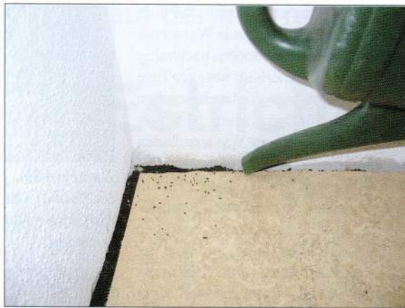
Einbau des Estrichfugensystems: Einbringen des granulatformigen Adsorptionsmittels ...
