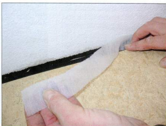
Es folgt der Einbau der Hochleistungs-Filtermembran ...
