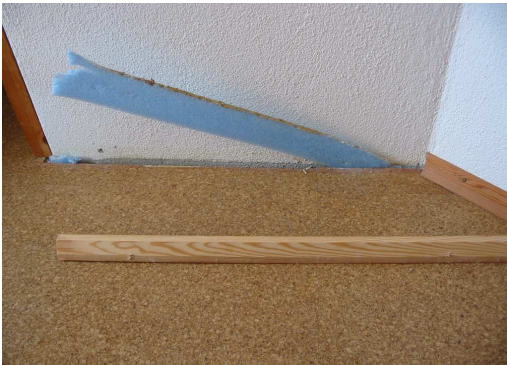
Abb. 1: Freilegen der Randfuge
