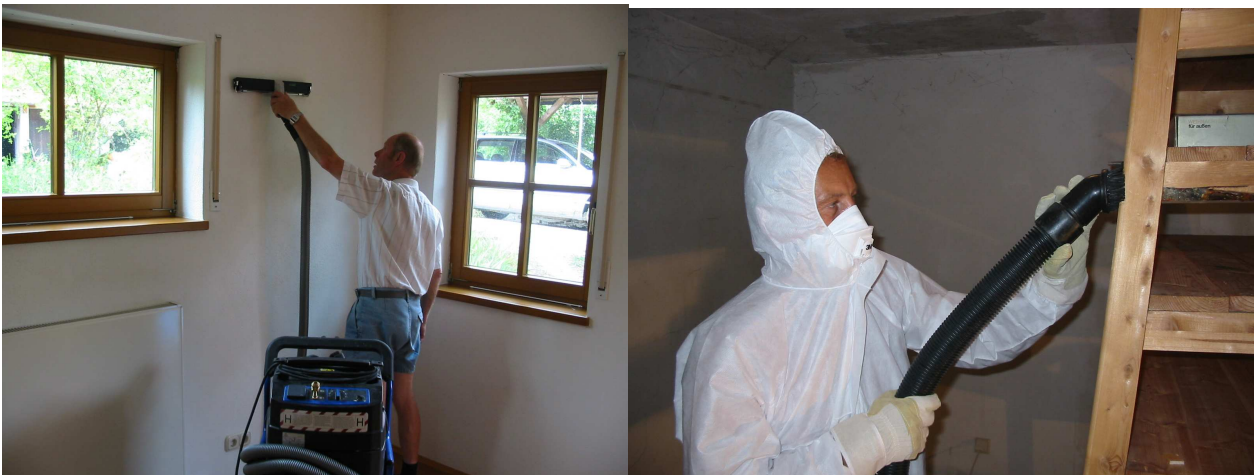
Abb. 4 und 5: Je nach Belastungsgrad sind bei Sanierungsarbeiten Arbeitsschutzmaßnahmen zu berücksichtigen (Bilder: Institut peridomus, www.peridomus.de )
