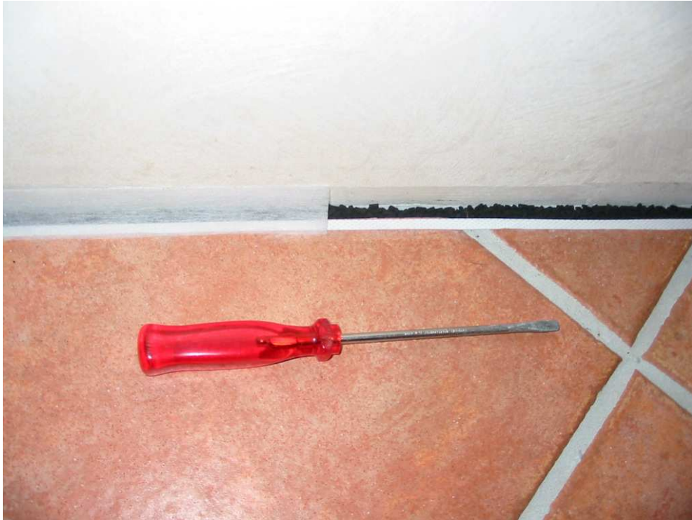
Abb. 3: Diffusionsoffenes Estrichfugensystem mit granulartförmigem Adsorbens (schwarz) und Partikelbindender Membran (weiß), um den kompletten Ausbau des Fußbodens incl. Estrich und Dämmung bei Schimmelpilzbefall im Unterboden zu vermeiden (Bild: Fa. welindo gmbh gesunde innenräume, www.welindo.de )
