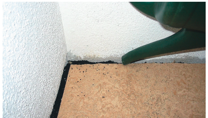
Das zweistufige Filterkonzept des diffusionsoffenen Estrichfugensystems dient zur einfachen, sicheren und preisgünstigen Abtrennung der Raumluft von einer Schimmelpilzbelastung unter einem schwimmend verlegten Estrich. Das schwarze Adsorptionsmaterial in der Fuge filtert gasförmige Emissionen von Schimmelpilzen aus dem Unterboden
