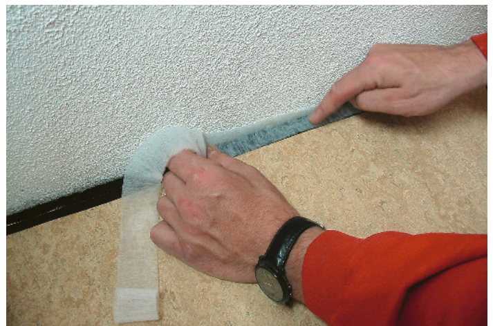
Über die Fuge wird ein weißes Hochleistungsfiltergewebe zur Partikelfilterung gespannt
