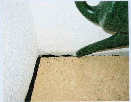
Einbringen eines Adsorptionsmittels zur Filterung von gasförmigen Schimmelpilzprodukten und Gerüchen
