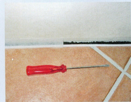
Das zweistufige Filterkonzept des diffusionsoffenen Estrichfugensystems zur einfachen und sicheren Abtrennung der Raumluft von einer Schimmelpilzbelastung unter einem schwimmend verlegten Estrich (das schwarze Adsorptionsmaterial in der Fuge filtert gasförmige Emissionen von Schimmelpilzen aus dem Unterboden, über die Fuge ist ein weißes Hochleistungsfiltergewebe zur Partikelfilterung gespannt).
