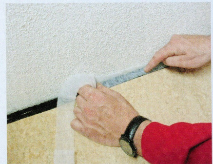
Einbau der Membran zur Filterung von partikelartigen Schimmelpilzbestandteilen
